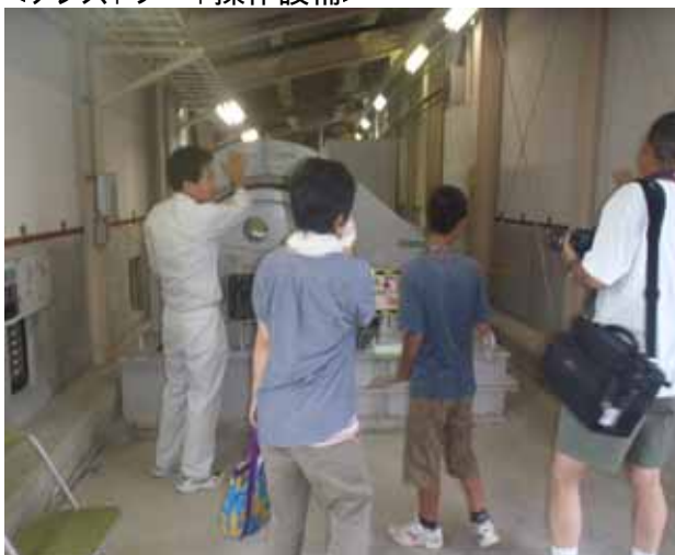
<クレストゲート操作設備>
