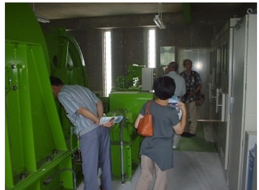
浄土寺川ダム
