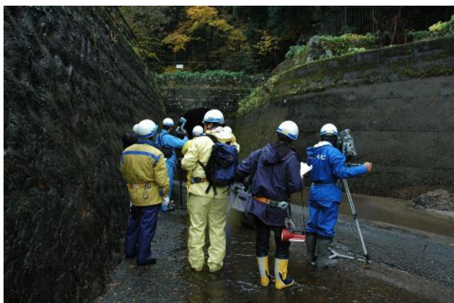
沈砂池 (導水路入口)
