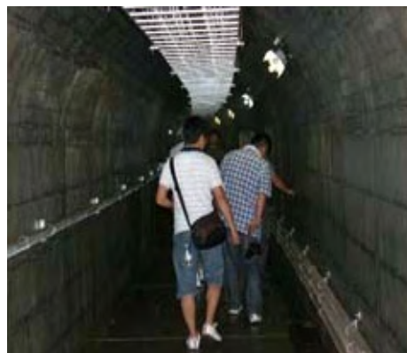
■堤体内通路見学
