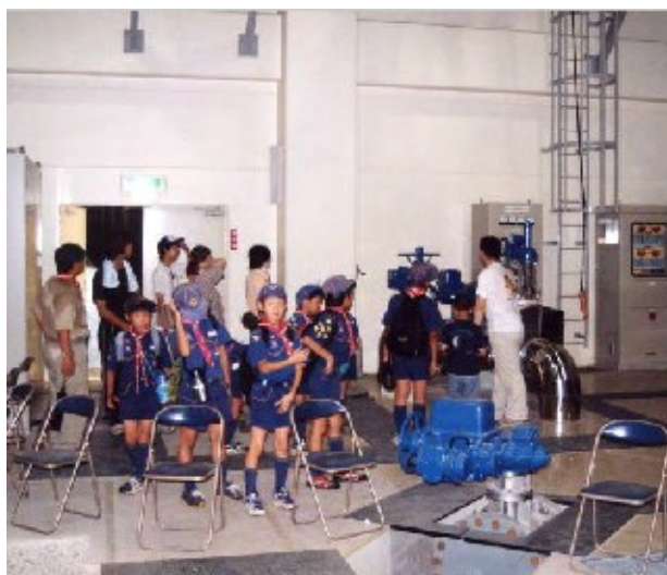
■維持放流棟内部
