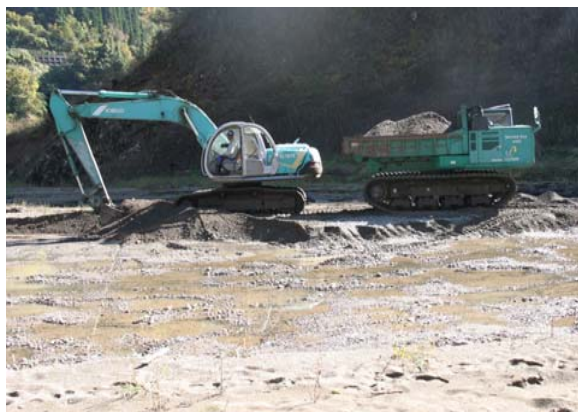
■貯水池の土砂撤去
