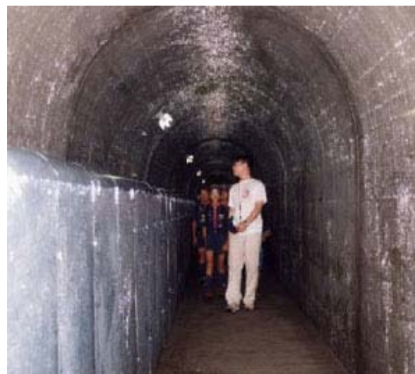
■ 下段監査廊からの下り通路
