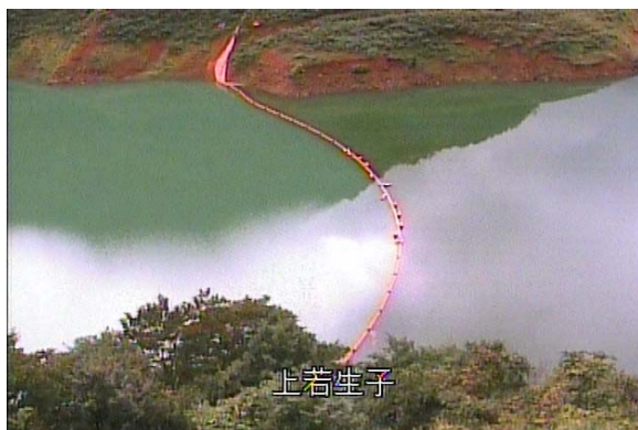
■濁水対策フェンス
