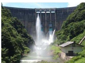
コンジットゲート設備見学
