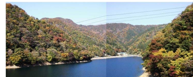
大谷付近(大谷橋からダム左岸側を撮影)
