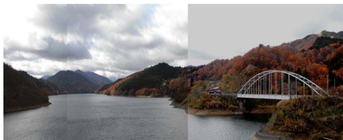
箱ヶ瀬橋下流(箱ヶ瀬橋上から下流側を撮影)
