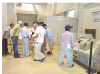
管理用発電設備見学
