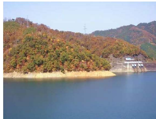
■管理支所周辺 (管理支玄関より周辺(ダム右岸側)を撮影)
