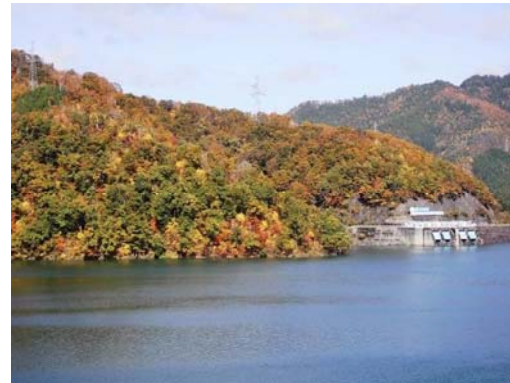
■管理支所周辺 (管理支玄関より周辺(ダム右岸側)を撮影)
