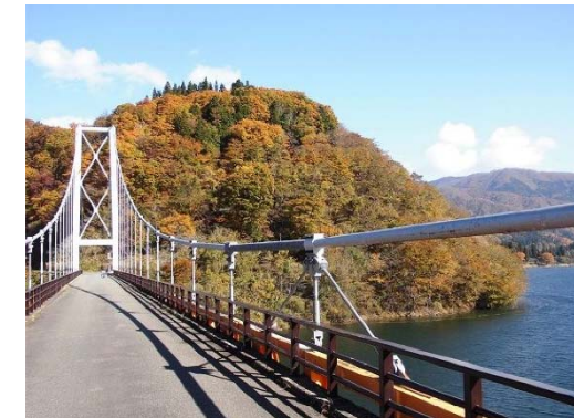
■箱ヶ瀬橋下流 (箱ヶ瀬橋上から下流側を撮影)
