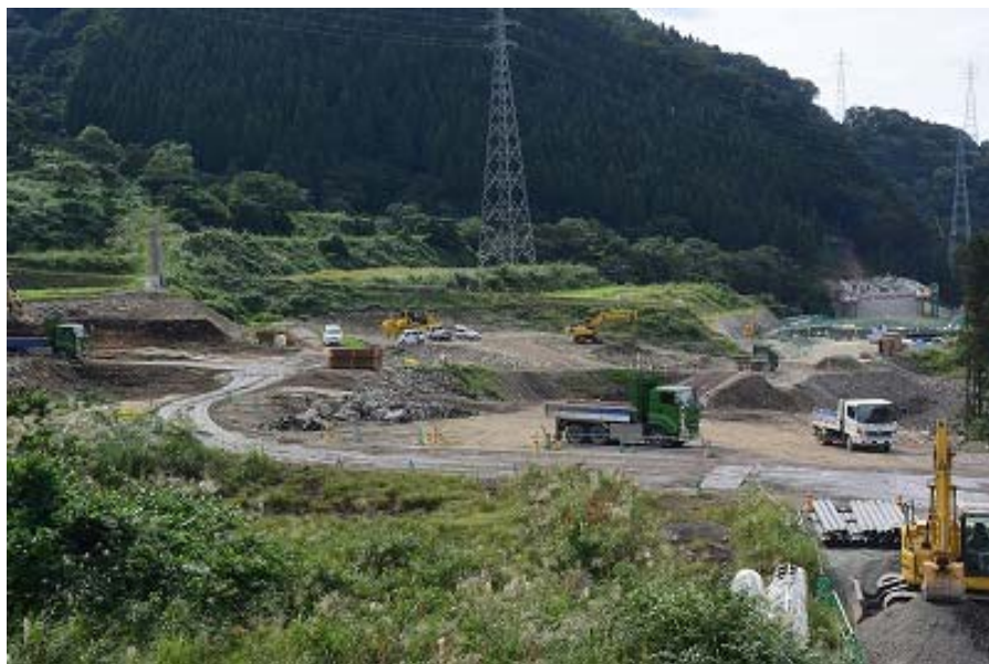
大野油坂道路荒島トンネル付近の工事の状況
