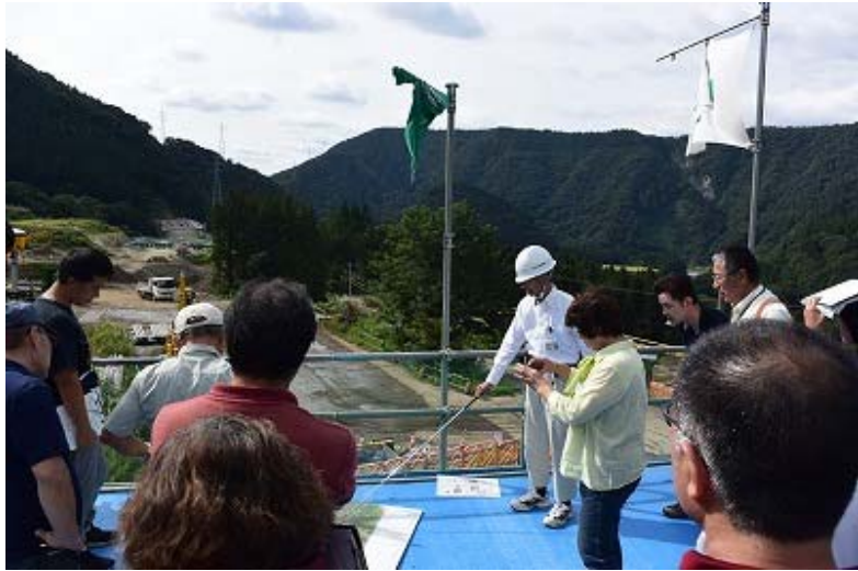
【荒島トンネル 工事現場見学】
