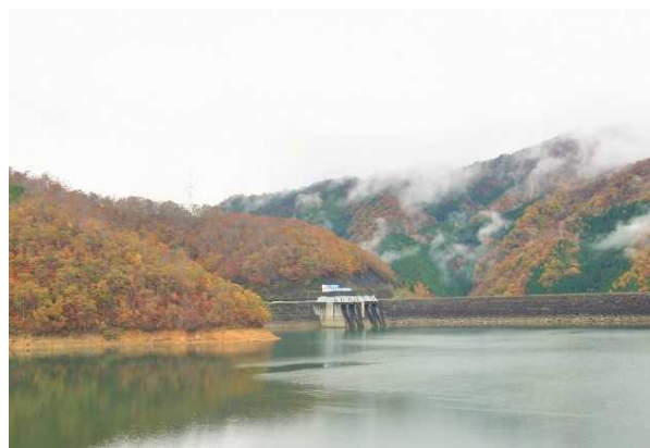
■管理支所周辺 (管理支所より周辺(ダム右岸側)を撮影)
