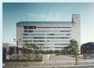
亀岡市役所（平成2年完成）
