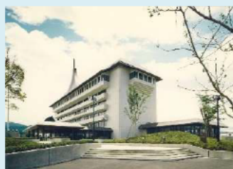
天理市役所（昭和59年完成）
