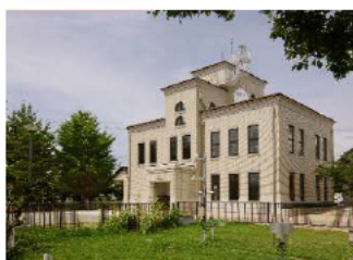
彦根地方気象台 保存・増築 （平成24年度完成）
