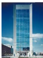
福井春山合同庁舎 （平成8年完成）
