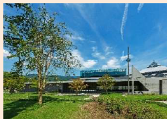
展示施設（平成30年完成）
