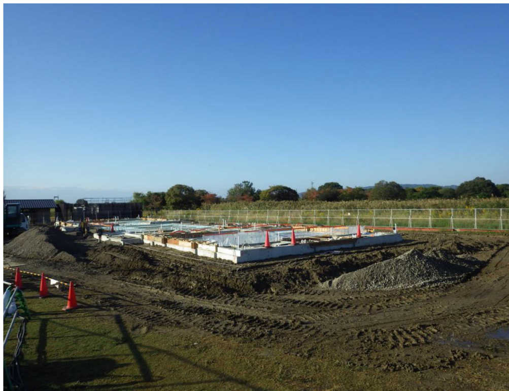
建物北、東基礎
