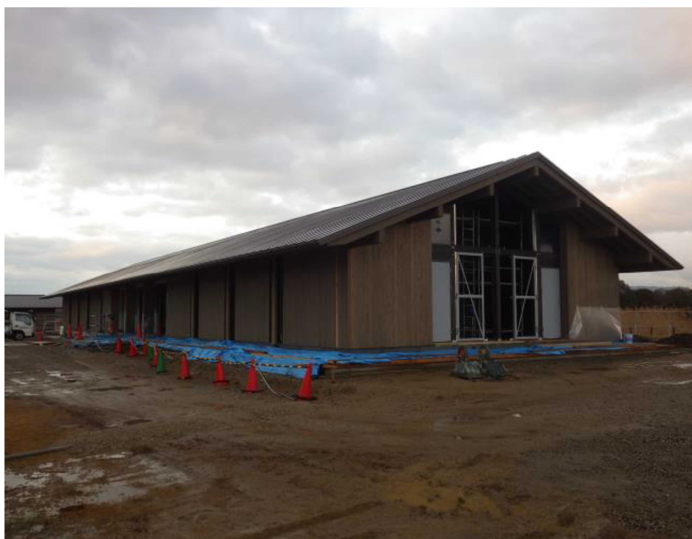
全景北、東外観
