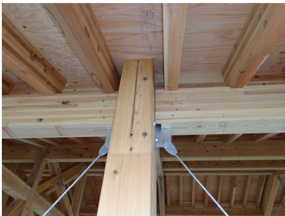
鋼棒ブレス上部
