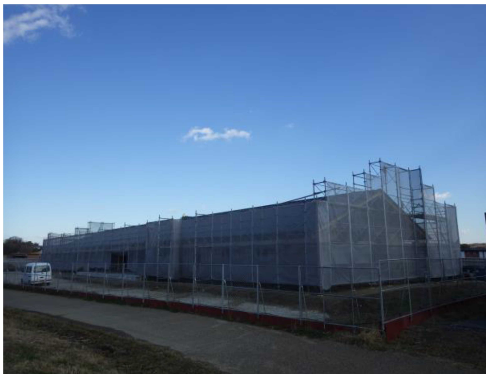
全景南、西足場
