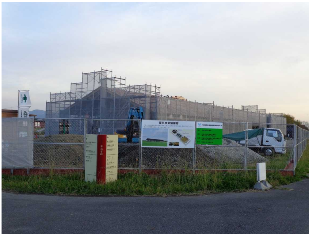
全景北、西足場
