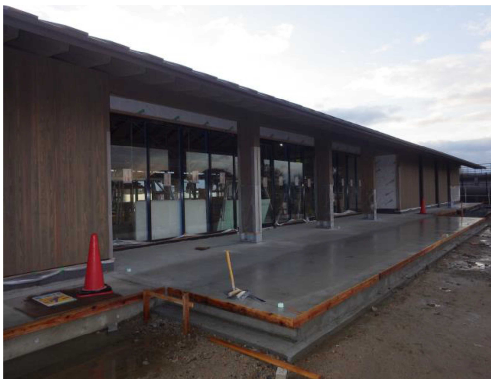
東面玄関廻り
