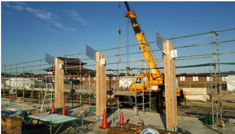
集成材柱設置
