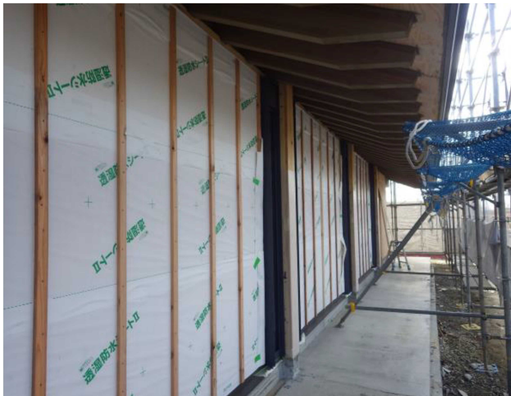
外壁下地状況
