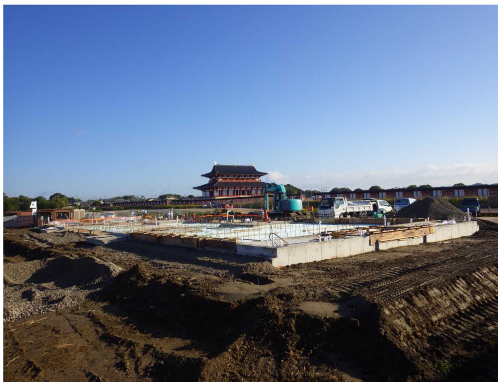
建物南、西基礎
