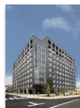
大津びわ湖合同庁舎 (平成24年完成・PFI事業)
