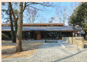
中立売休憩所(平成31年完成)
