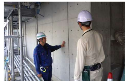
監督業務の実施 (コンクリート面の品質確認状況)
