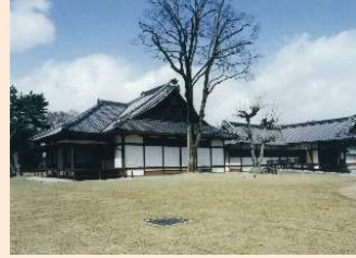
閑院宮邸跡復原・保存（平成18年完成）
