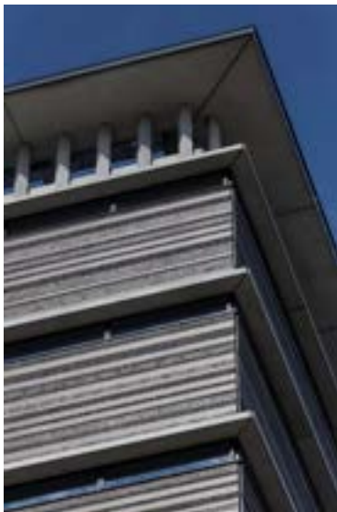
◀超高压水で削り出した外壁
