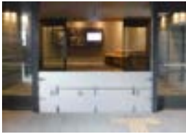
▲防潮板を使用した様子
