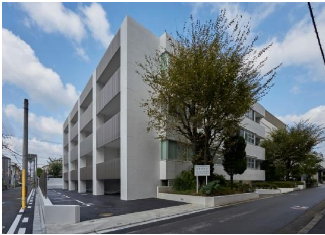
別館南面外観
