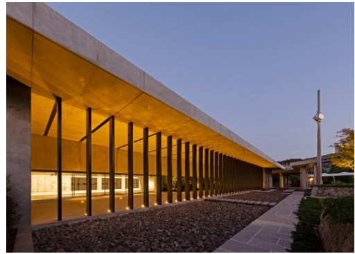
連絡歩廊 (照明器具)
