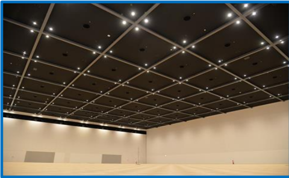
展示ホール天井写真
