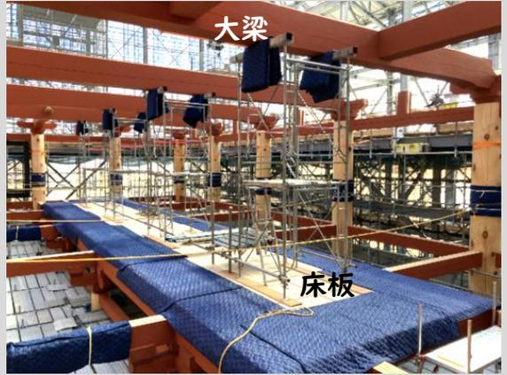
春の上棟を目指し、床板の設置を行っております。床板を設置後、長さ12mの大梁が重さに耐えられるようにステンレス支柱を設置していきます。
