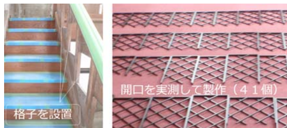
格子金物製作 写真-4 階段
