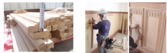
腰板の施工状況 (材料検収、割付) 写真-3 事務室内装飾 ～蛇腹・腰板～
