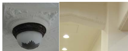
階段室天井 (鋼板製) 廊下梁型 (漆喰) 写真-6 天井・梁型装飾 (レリーフ)
