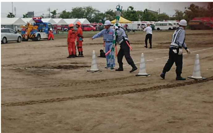
道路啓開訓練
