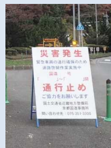
通行止め看板の設置
