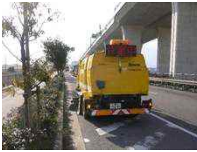
路面清掃作業
