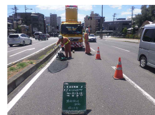
応急的な補修
