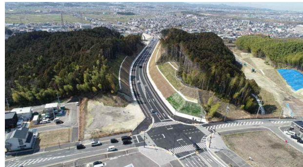
起点側より終点側を望む
