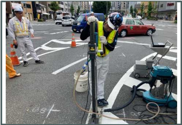
国道1号（京都府京都市）
