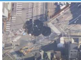
1月31日時点の 事故現場の状況
