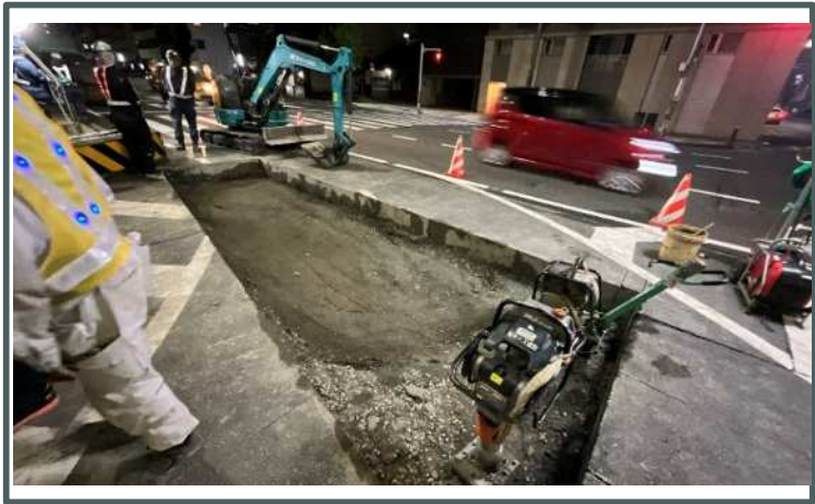
国道1号（京都府京都市）
