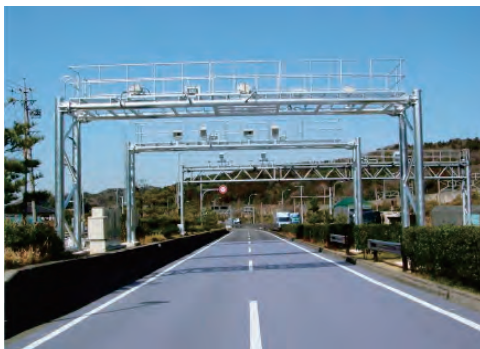
車両重量自動計測装置による計測
