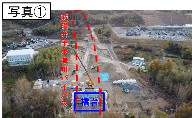
↑青谷川橋の橋梁下部工事を進めています
