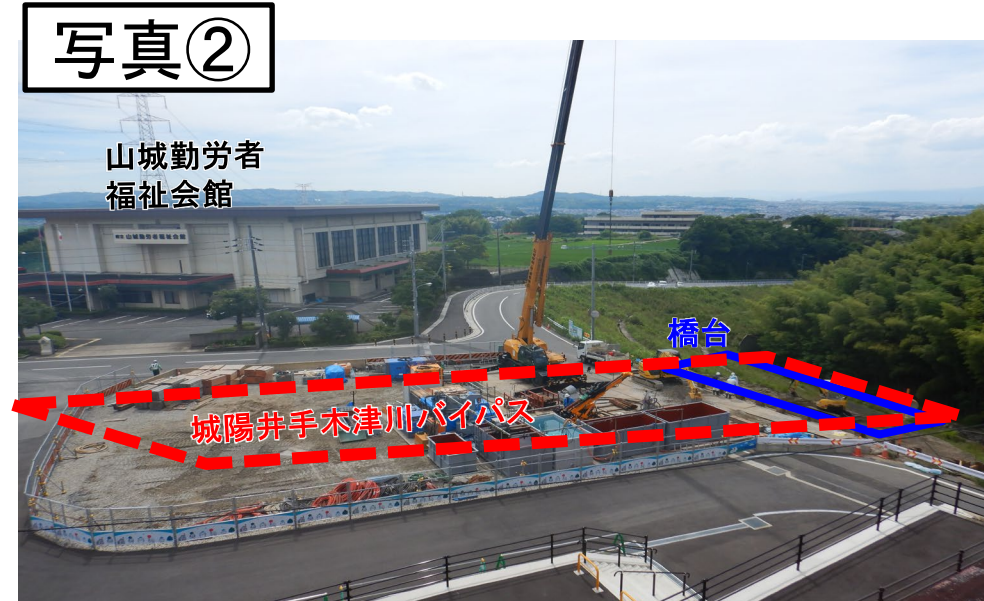
↑才田川橋の橋梁下部工事を施工していきます
