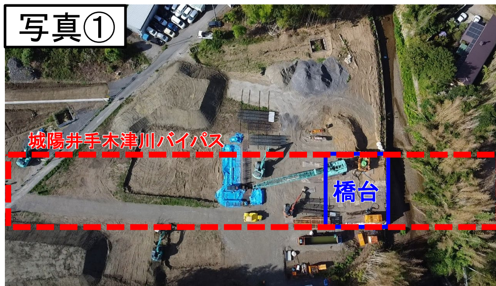
↑青谷川橋の橋梁下部工事を進めています
