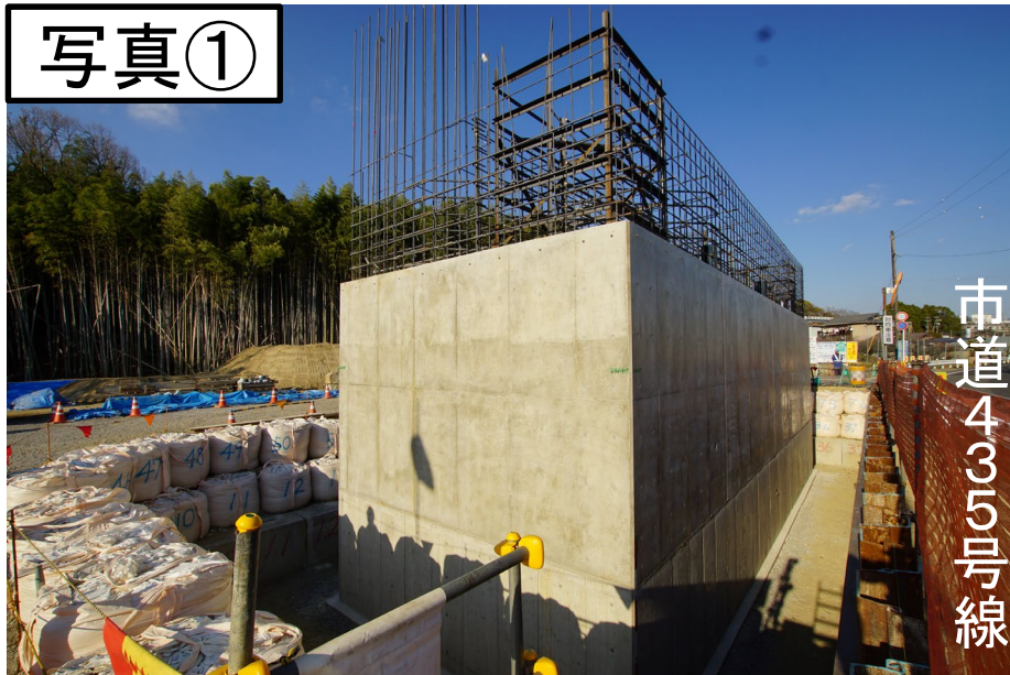
↑青谷川橋の橋梁下部工事を施工しています
