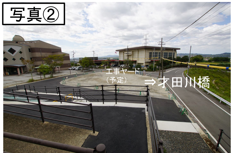
↑才田川橋の準備工事として町道迂回路が完成
