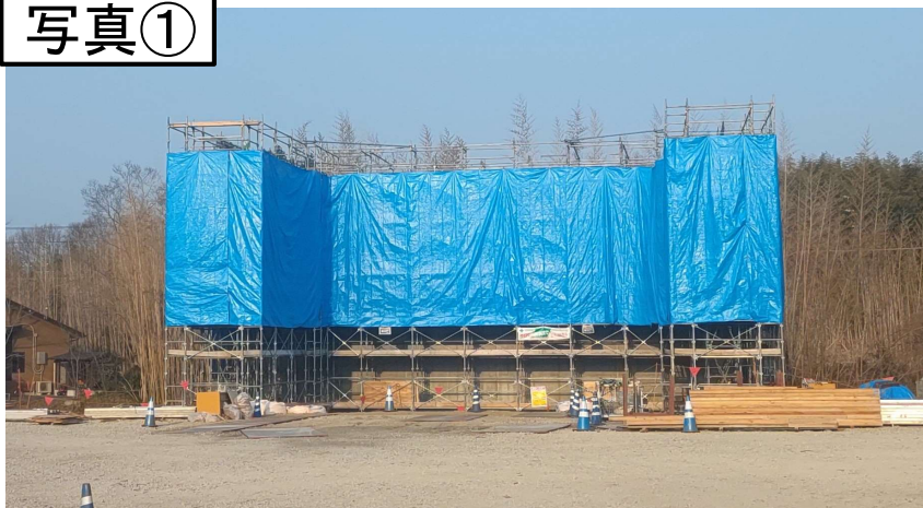
↑青谷川橋の橋梁下部工事を進めています
