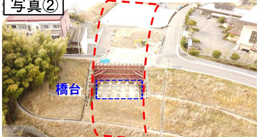
↑才田川橋の橋梁下部(A2橋台)工事を進めています。現在、杭基礎工事が完了しました。
