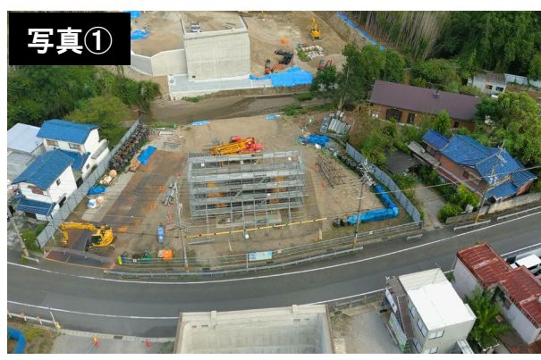
写真① 青谷川橋P2橋脚を施工しています。
