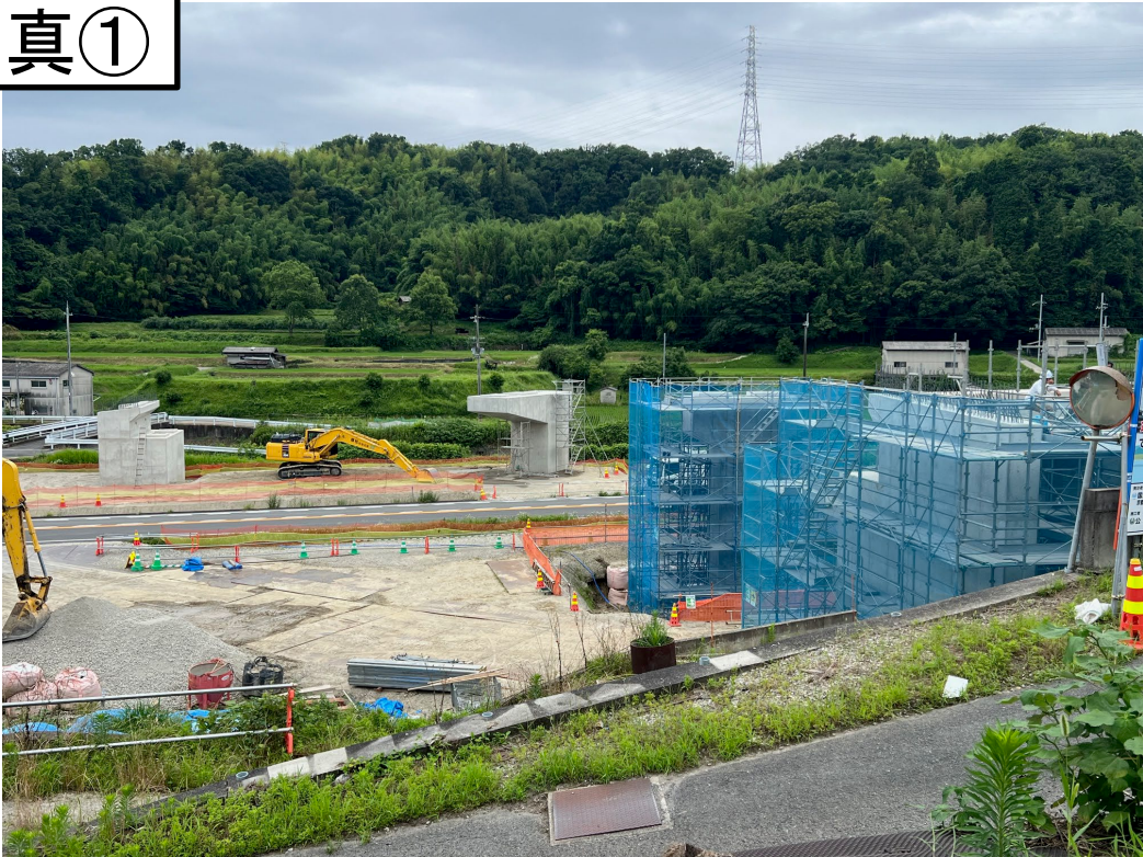
↑国道163号を跨ぐ橋の下部工事を進めています
