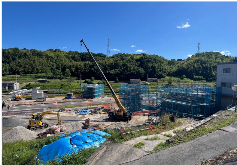
↑国道163号を跨ぐ橋の下部工事を進めています
