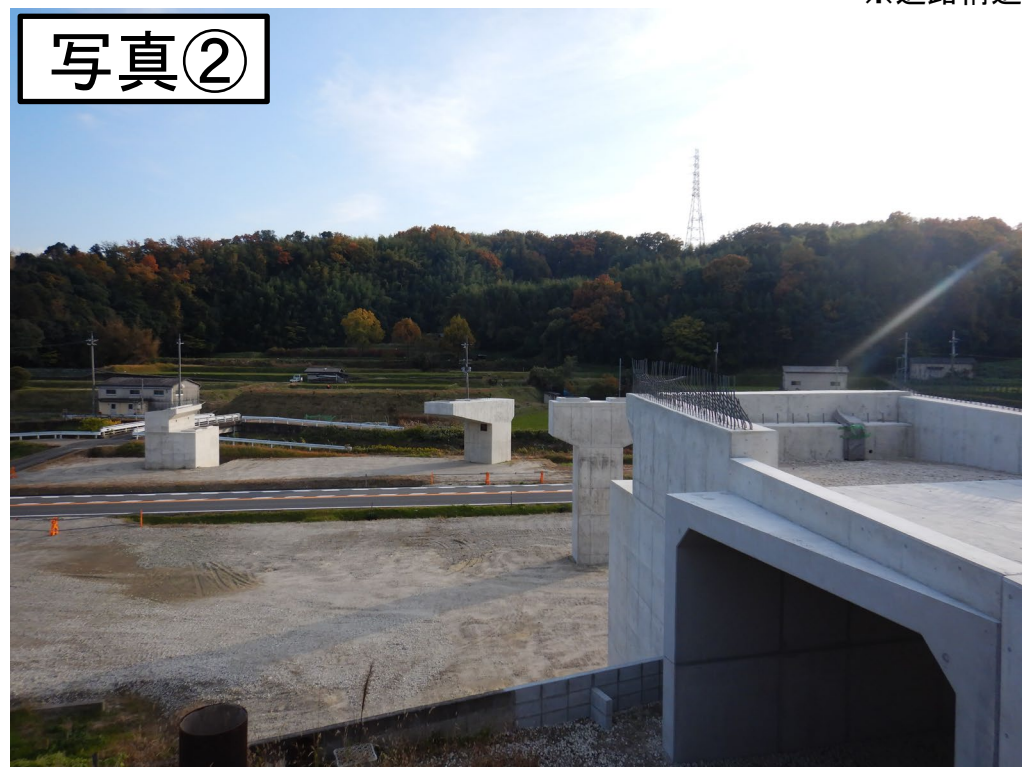
↑国道163号を跨ぐ橋の下部。
