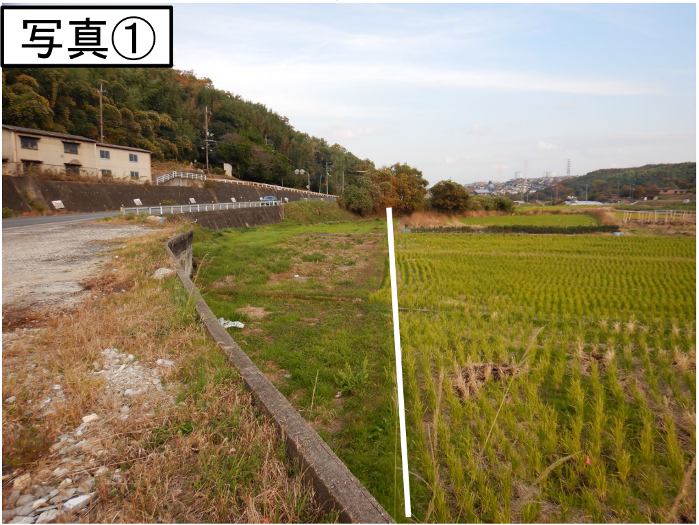
↑今後、国道163号と白線の間で盛土工事を行う予定です。
