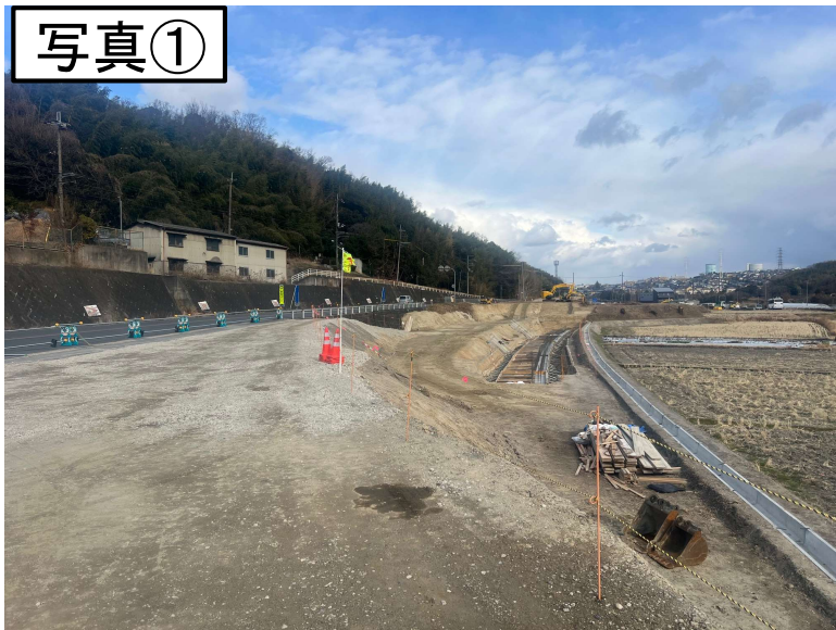
↑盛土の準備工事として側溝の隣に プレキャストコンクリート擁壁を施工しています。
