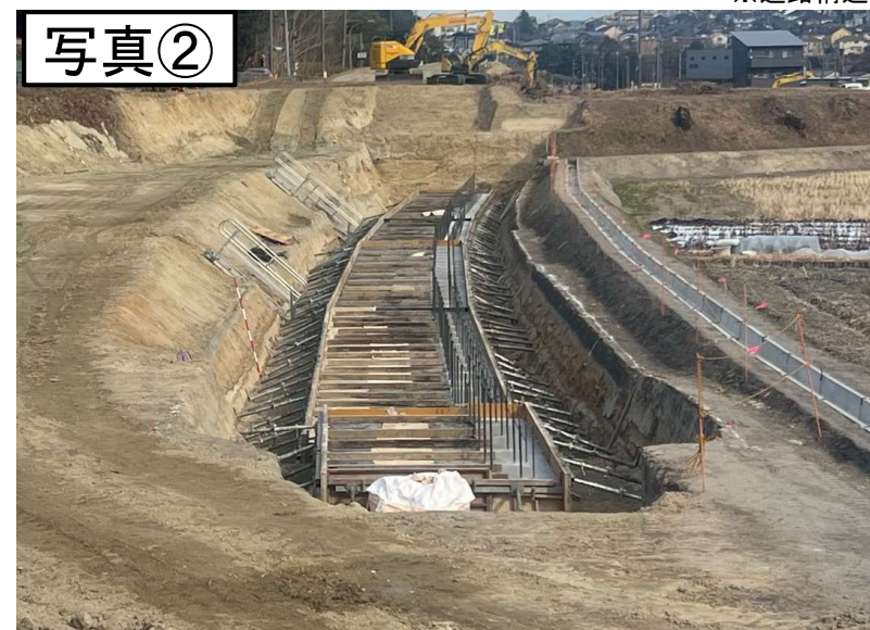
↑コンクリート擁壁の底版を現場打ちしている様子です 型枠を使用してコンクリートを成形しています
