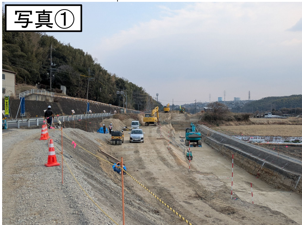
↑盛土の準備工事として側溝の隣に プレキャストコンクリート擁壁を施工する予定です
