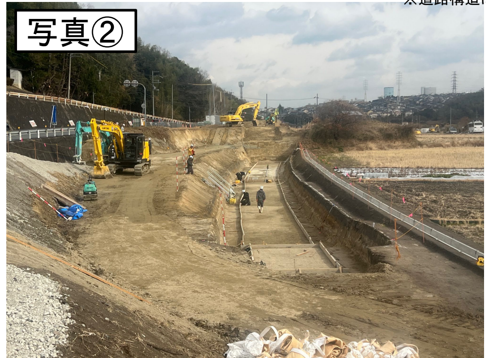
↑プレキャストコンクリート擁壁の施工準備として地盤 改良工事をしています
