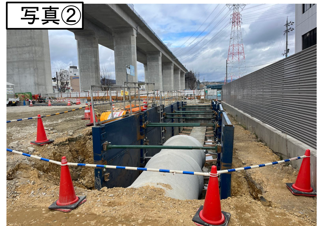
↑国道24号の排水管を施工しています
