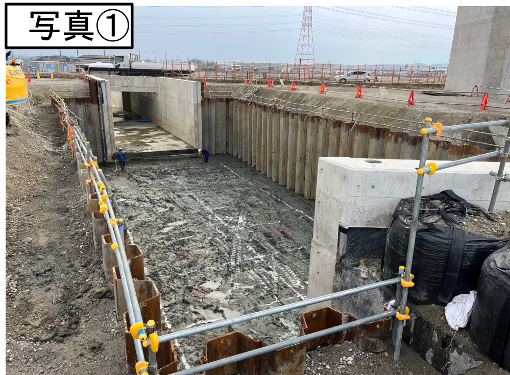
↑国道24号を横断するアンダーパスを施工しています
