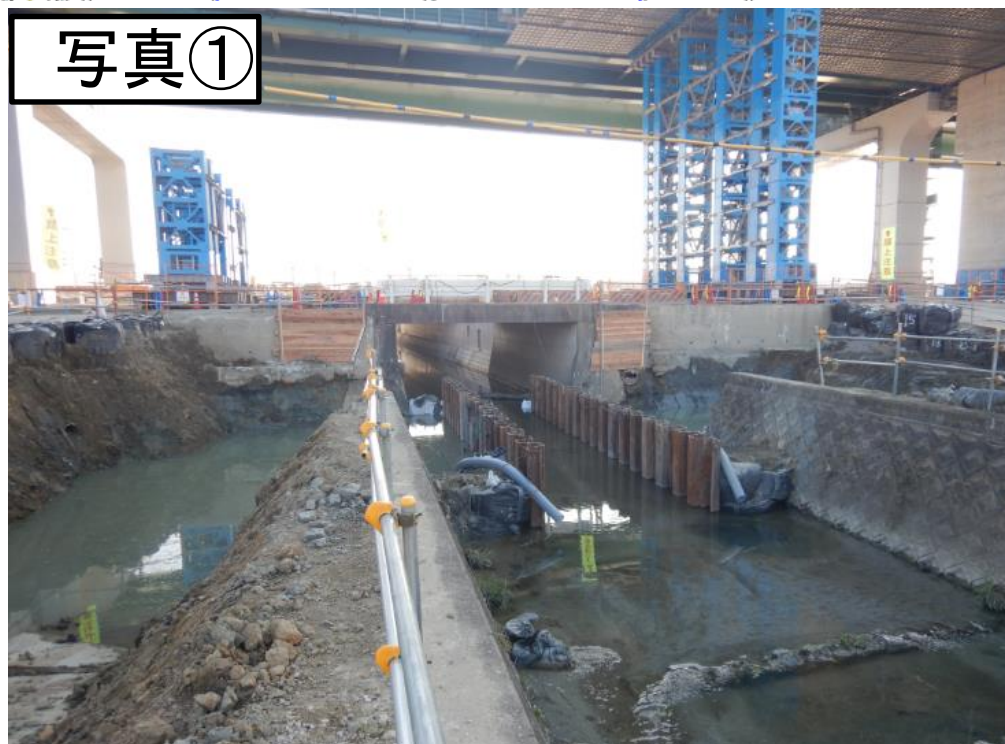
↑川を横断する門型カルバートを施工しています
