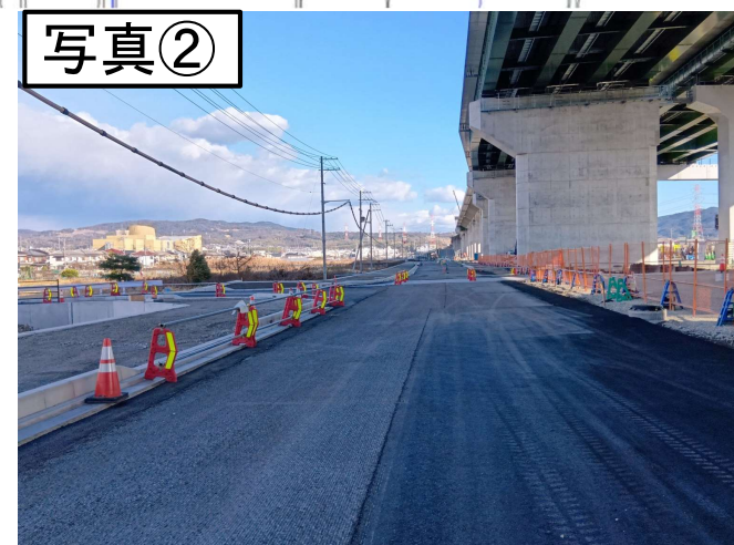
↑縁石などの構造物工事が完成し 舗装工事が基層まで進んでいます
