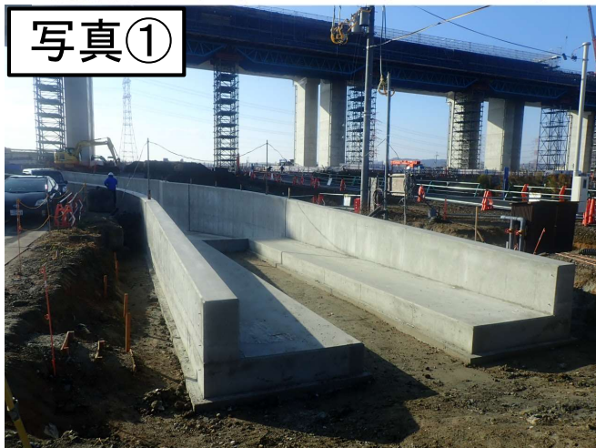
↑国道24号を横断するアンダーパスのうち 北側の逆L型擁壁が完成しました
