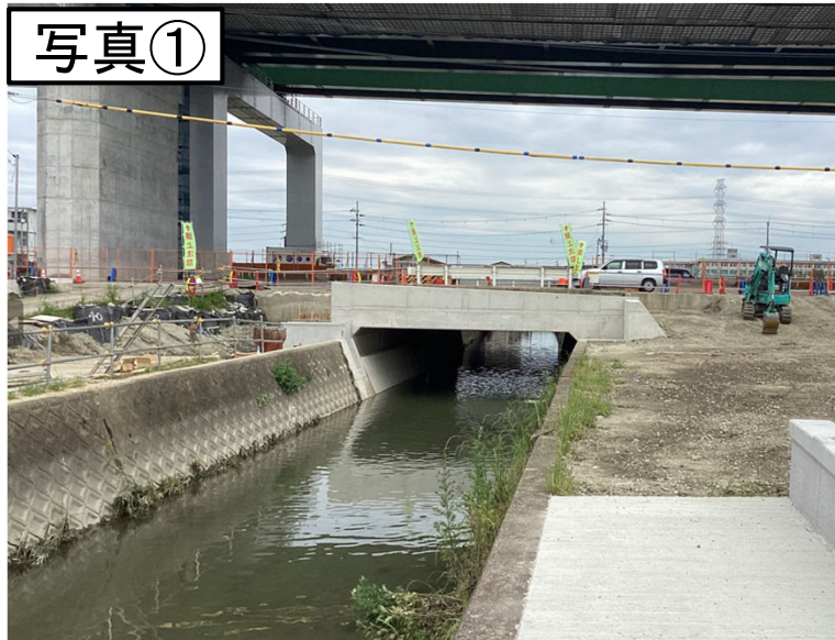
↑川を横断する門型カルバートが完成しました
