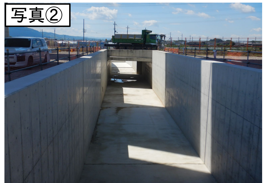
↑国道24号を横断するアンダーパスを施工しています
