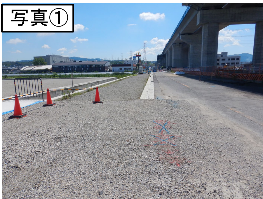
↑歩道の舗装工事を進めています
