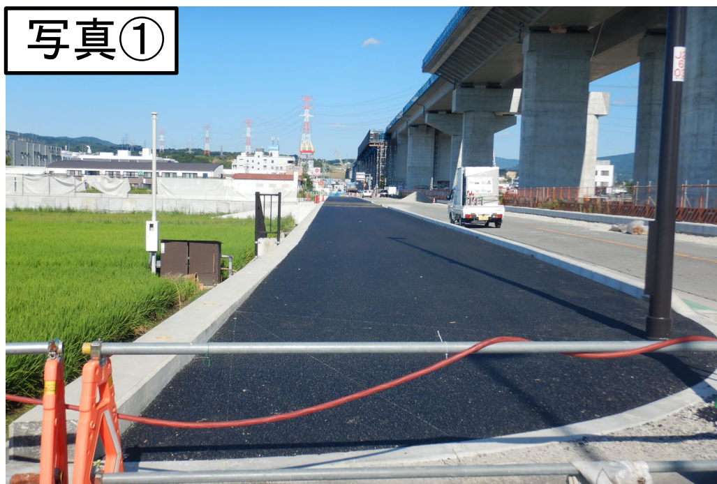
↑歩道の舗装工事を進めています。
