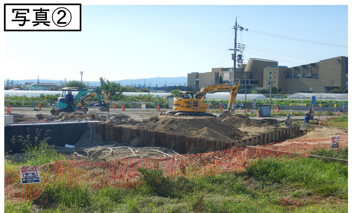
↑国道24号を横断するアンダーパスを施工しています。
