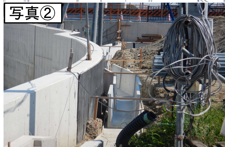
写真② ↑市道11号ボックスの右側にて、排水をするための構造物を施工しています。
