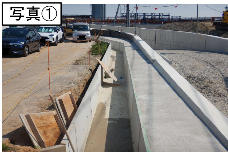
写真① ↑市道11号ボックスの左側にて、排水をするための構造物ができています。
