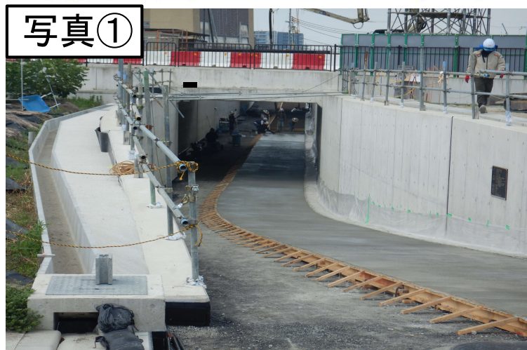
↑市道11号ボックスの南東にて、コンクリートの舗装工を行っています
