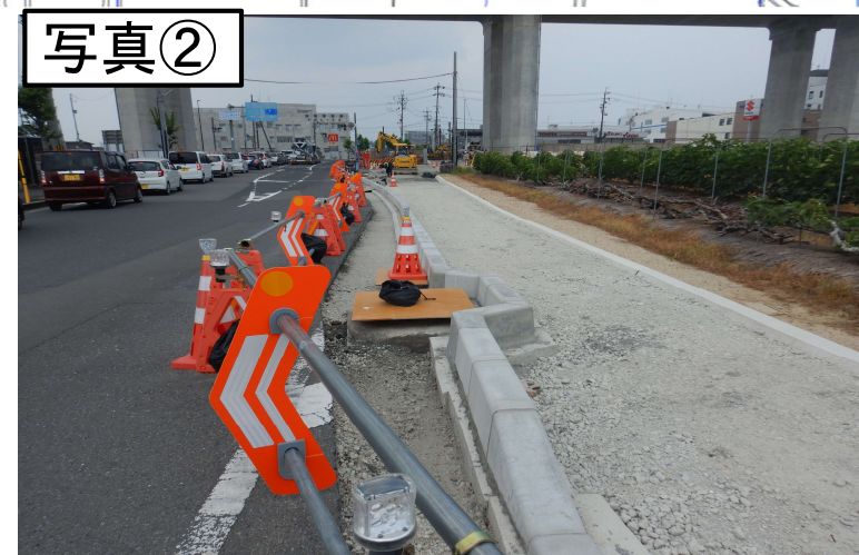
↑保険センター前の交差点南側にて、縁石と台付管の施工を進めています。
