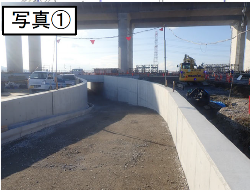
↑国道24号を横断するアンダーパス底部に路盤となる砕石を敷設しました
