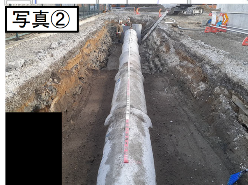
↑引き続き調整池からの放流管を施工しています
