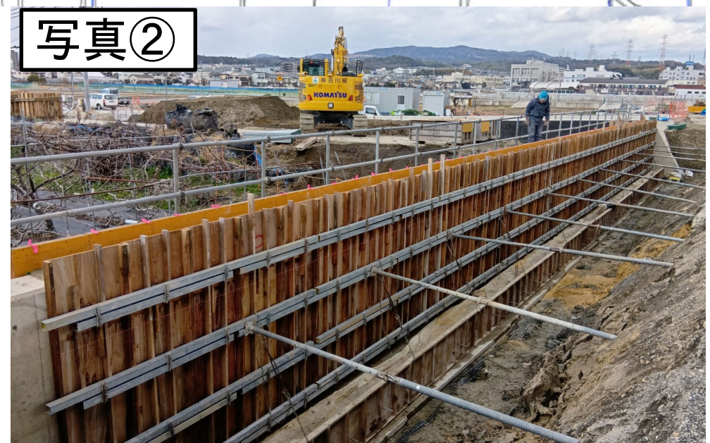
↑市道11号付近で逆T字型擁壁の施工を行っています 写真はコンクリートの養生を行っている様子です
