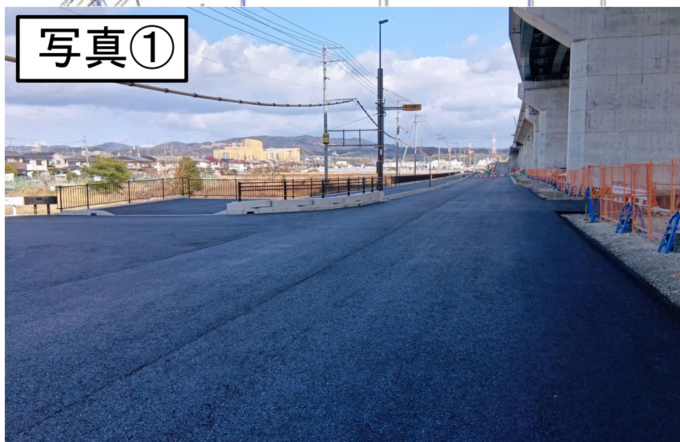
↑近鉄線より西側の下り線の舗装が表層まで完成しました
