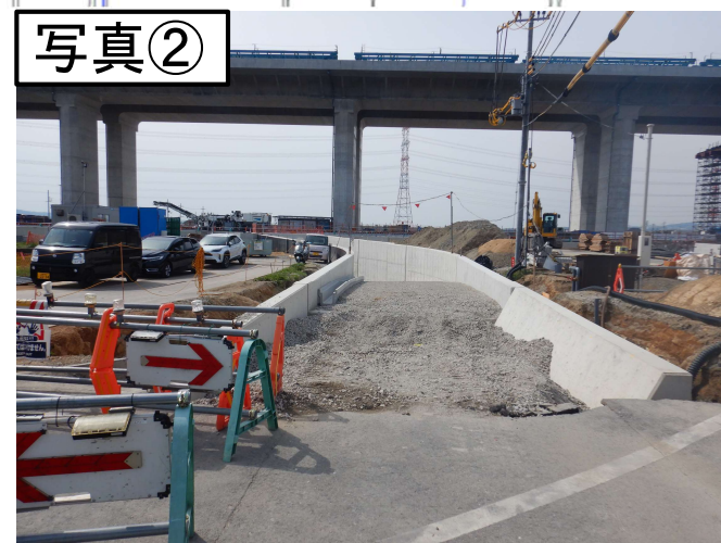
↑市道11号付近のボックスにて、擁壁ができてきました。
