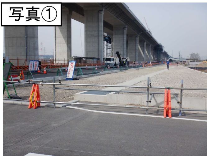
↑現在舗装工事を行っています。
