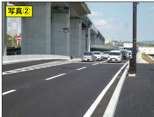
城陽橋付近状況
