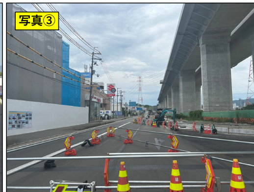
消防本部前交差点付近状況
