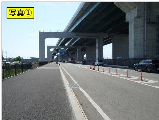
南側ルート通行状況
