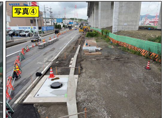
縁石施工状況
