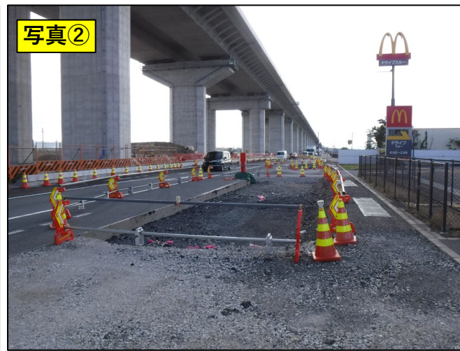
消防本部前交差点付近西側状況
