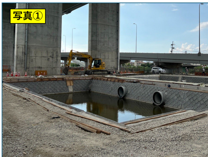
調整池設置状況
