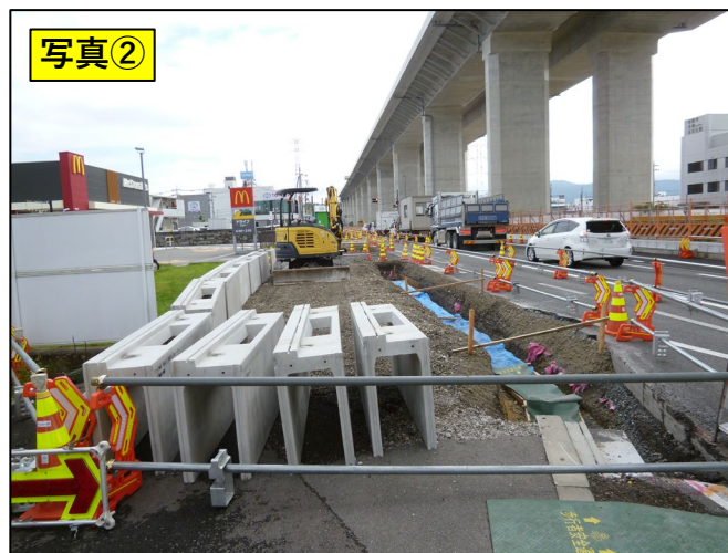
消防本部前交差点付近西側状況
